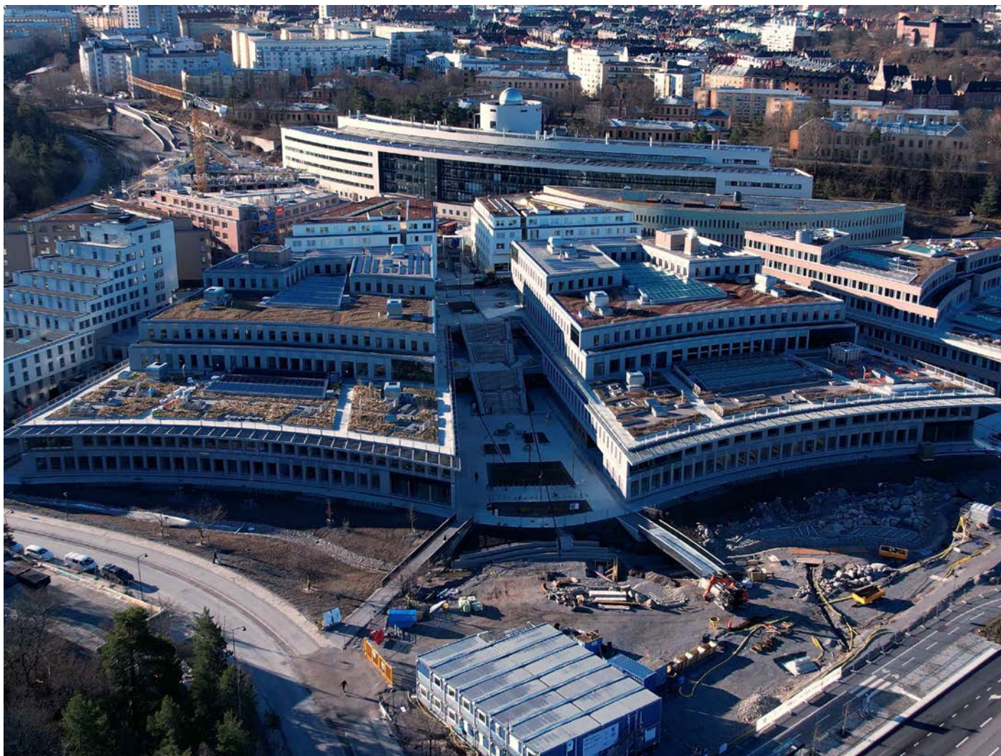
Den nya 70 000 kvm stora utbildnings- och forskningsanläggningen Albano Campus på Stockholms Universitet är nu uppdaterad med helt ny AV-teknik.
